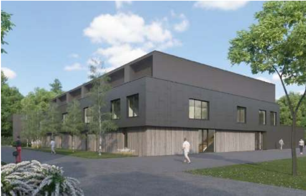
Slika 7.4: Severna fasada športne dvorane
